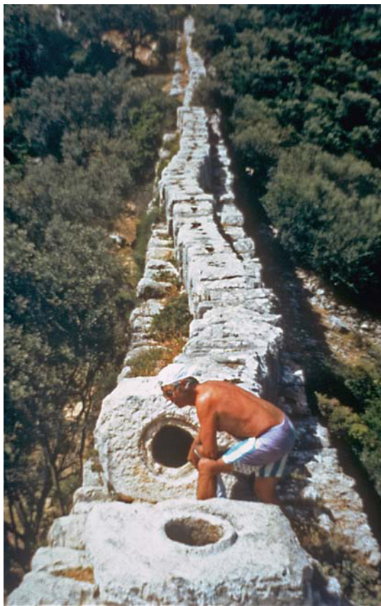
Abb. 18.6: Druckleitung aus massivem Stein in Patara (Türkei).
