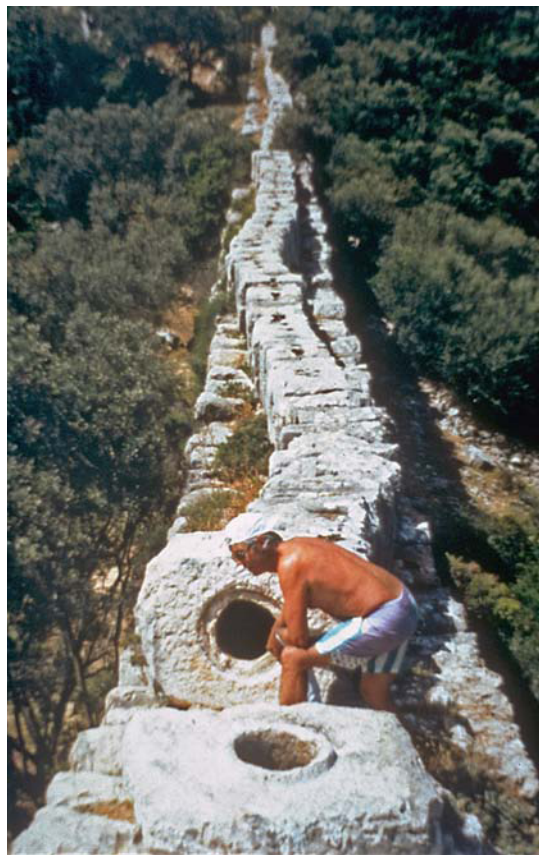
Abb. 18.6: Druckleitung aus massivem Stein in Patara (Türkei).
